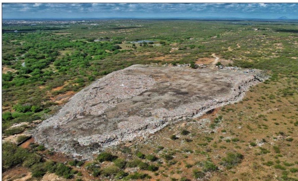
Figura 4 – Imagem aérea do lixão de Caicó/RN
