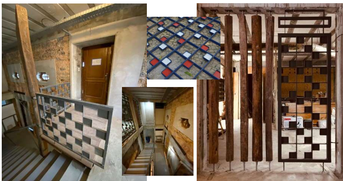
Figura 5: Composição com grade reaproveitada e madeiras da desmontagem do edifício - divisória entre a garagem e o acesso aos apartamentos.
