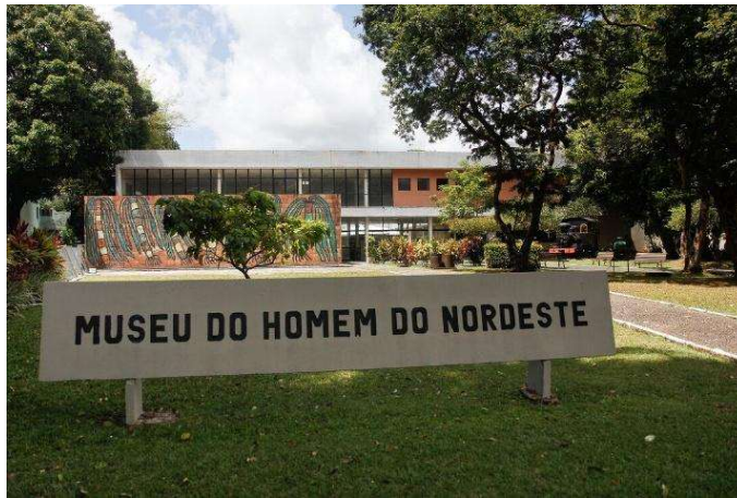
Figura 1: Edifício Gil Maranhão, 2023.
