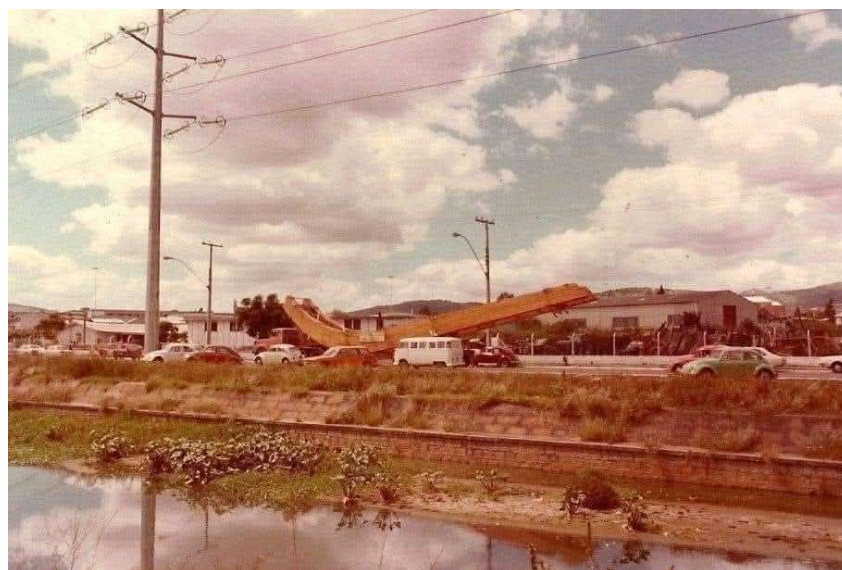
Figura 3: Produção de viga em madeira laminada colada de pinho Araucária nos anos 1970 pela empresa Esmara Estruturas de Madeira Ltda.
