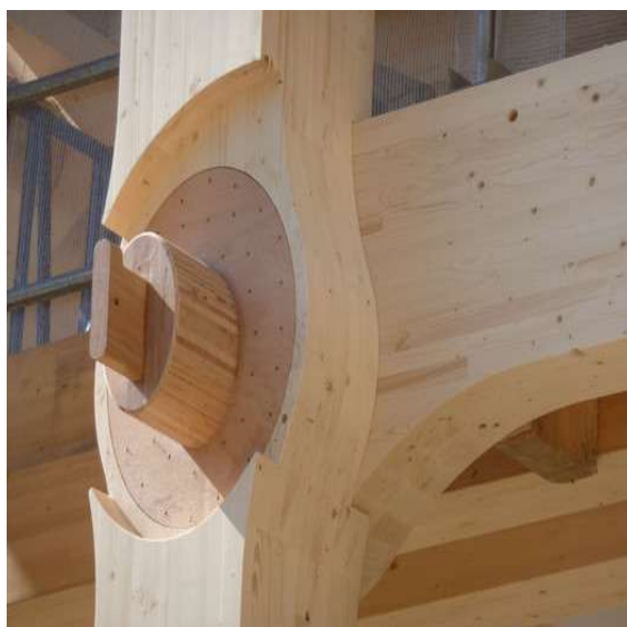
Figura 11: Detalhe da treliça espacial do Museu de Arte de Aspen (a); detalhe da junção entre pilar e viga no Edifício de Escritórios Tamedia (b)
