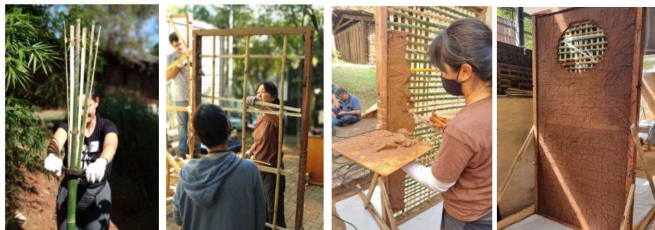
Figura 1: Prática da taipa tipo japonesa, respectivamente: corte do bambu (esq.), confecção da trama (centro), aplicação da terra (centro) e pós-secagem (dir.), 2023.
