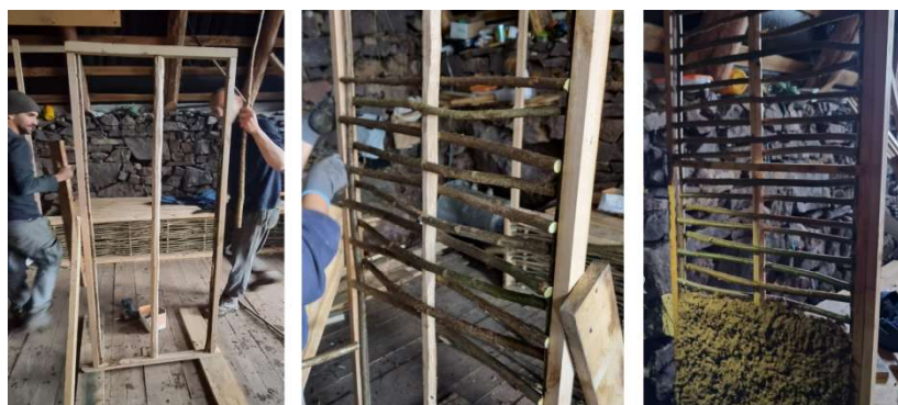
Figura 2: Prática da taipa de mão, respectivamente: confecção da trama (esq.), painel de madeira serrada (centro), aplicação da terra (centro) e pós-secagem (dir.), 2023.
