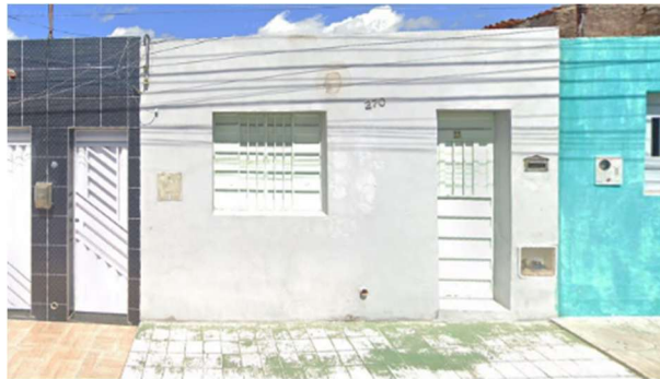
Figura 3: Fachada frontal da residência em estudo.
