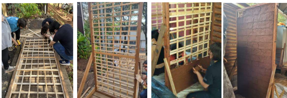
Figura 2: Prática da taipa de mão, respectivamente: confecção da trama (esq.), painel de madeira serrada (centro), aplicação da terra (centro) e pós-secagem (dir.), 2023.
