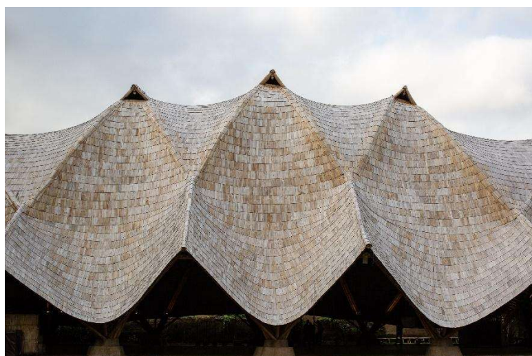
Figura 16: Tectônica têxtil decorrente das esterilhas de bambu acompanhando a dupla curvatura das gridshells anticlásticas.
