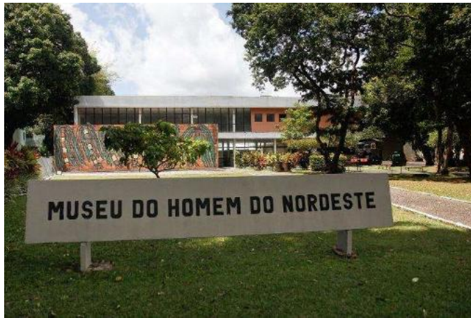
Figura 1: Edifício Gil Maranhão, 2023.
