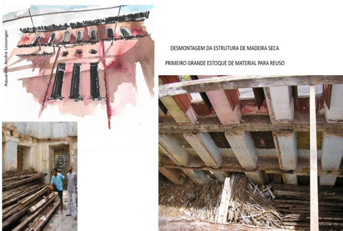
Figura 4: Composição de aquarela e imagens da primeira desmontagem da fachada voltada para a Baía de Todos os Santos (2009-2010).
