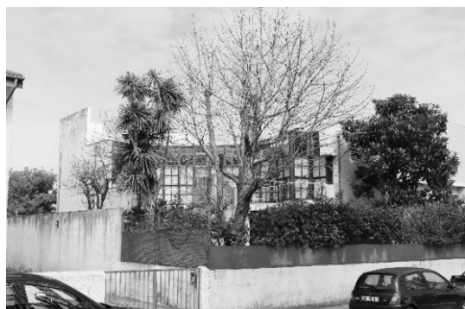
Figura 13: Fotografia da Casa Beires (Casa Bomba)
