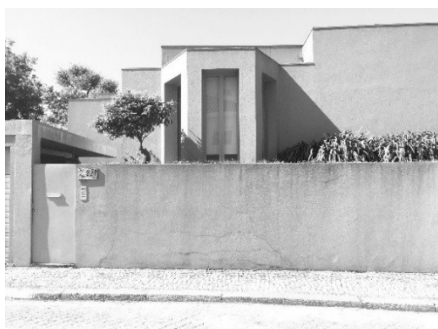
Figura 11: Fotografia da Casa Carlos Siza
