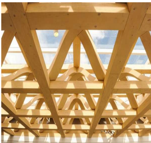
Figura 11: Detalhe da treliça espacial do Museu de Arte de Aspen (a); detalhe da junção entre pilar e viga no Edifício de Escritórios Tamedia (b)
