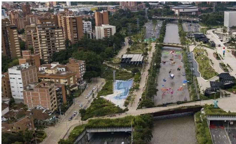
Figura 5: Registro Fotográfico – Conexões transversais entre as margens de Medellín na primeira etapa implantada do projeto
