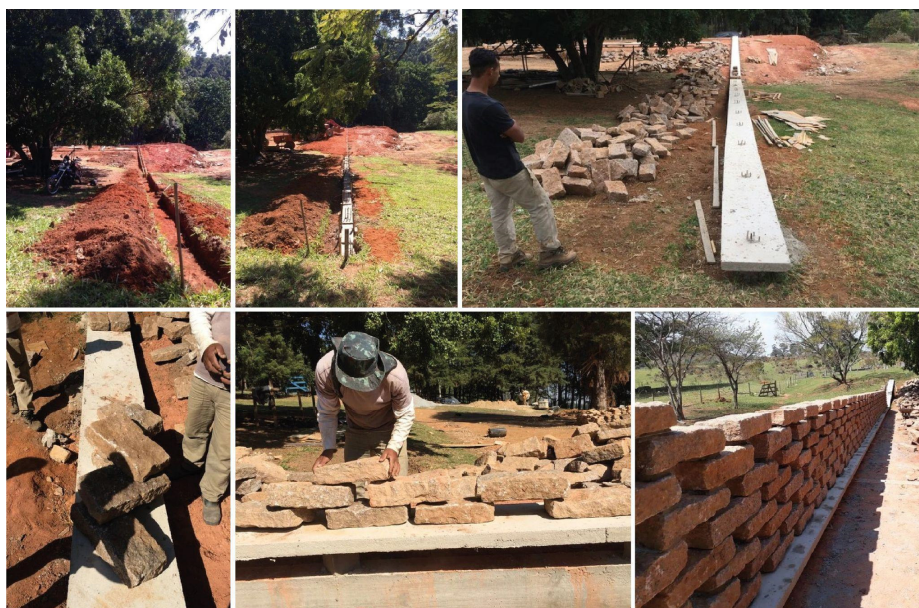
Figura 7: Processo de construção do septo perpendicular da capela.
