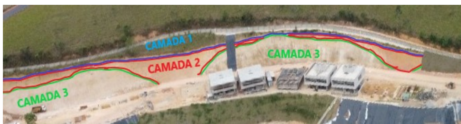
a) Camadas de solo no talude.
