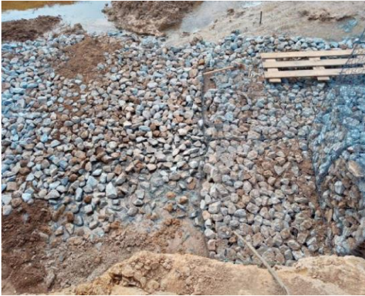
Figura 15 – Enrocamento na fundação
