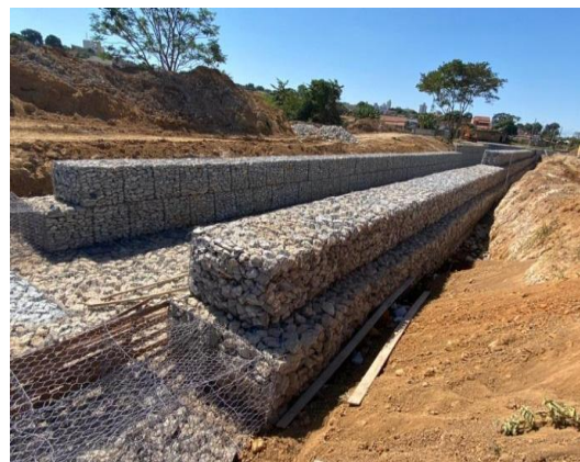
Figura 20 – Contenções laterais em gabião tipo caixa
