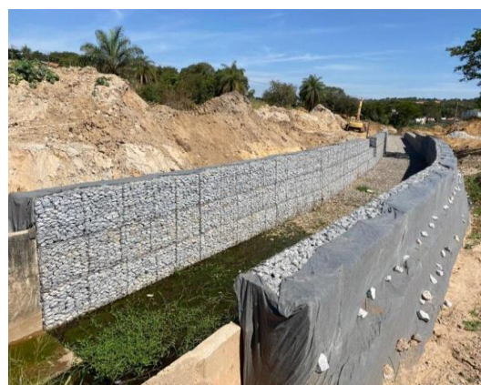
Figura 24 – Vista da obra do canal e preparação para o aterro
