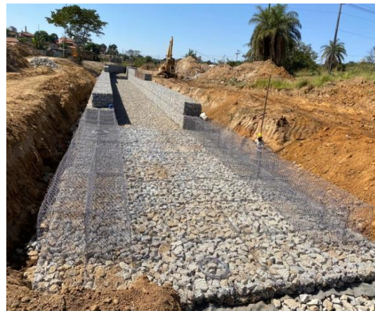
Figura 18 – Evolução da execução dos muros
