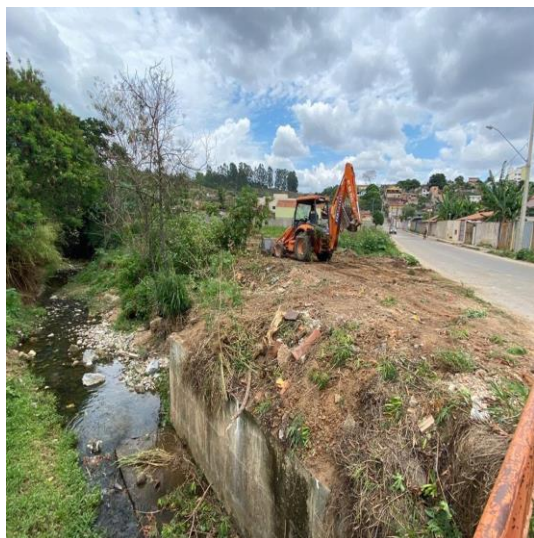
Figura 7 – Limpeza superficial do terreno
