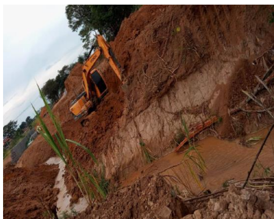
Figura 13 – Movimentação de terra
