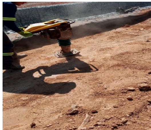
Figura 28 – Compactação com compactador de solo à percussão (sapo)
