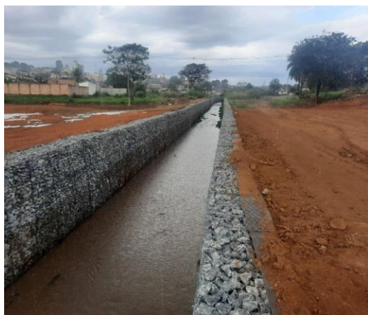
Figura 29 – Finalização da obra e terreno limpo
