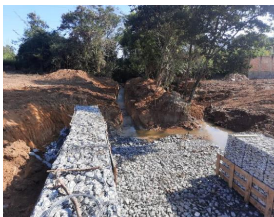
Figura 21 – Construção do canal
