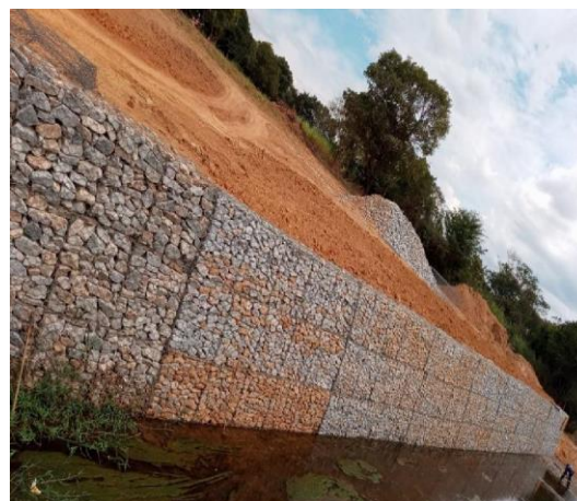
Figura 30 – Vista lateral da contenção de gabião
