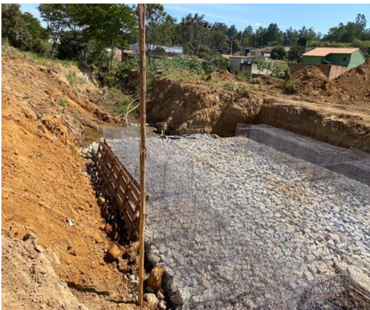
Figura 17 – Execução dos muros de gabião tipo caixa
