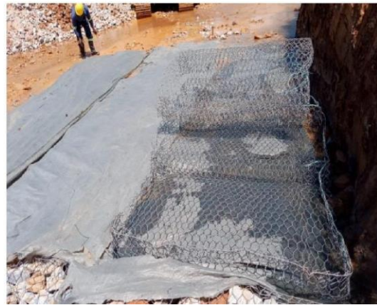
Figura 16 – Aplicação de geotêxteis na base
