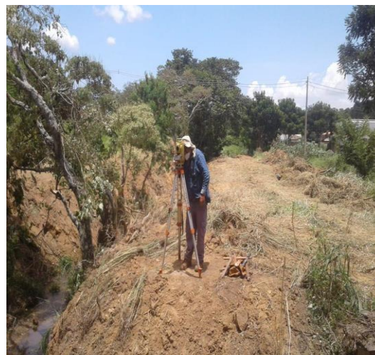
Figura 12 – Locação da obra
