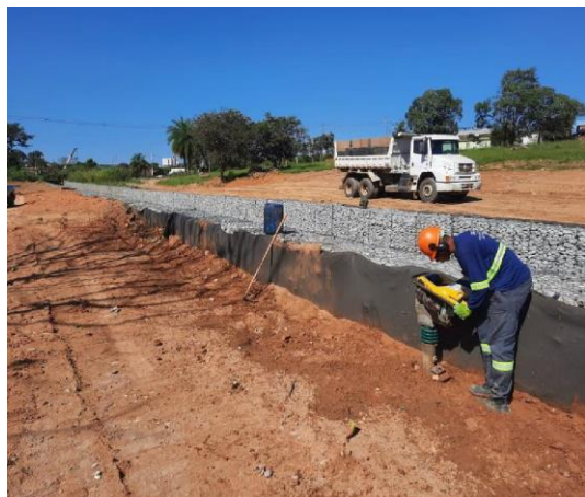
Figura 27 – Compactação do aterro
