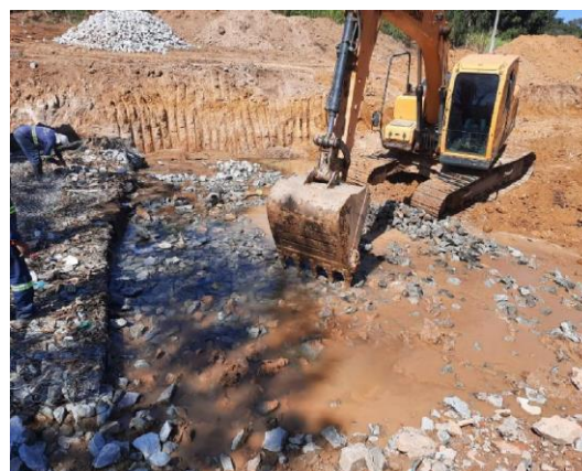
Figura 14 – Execução da fundação
