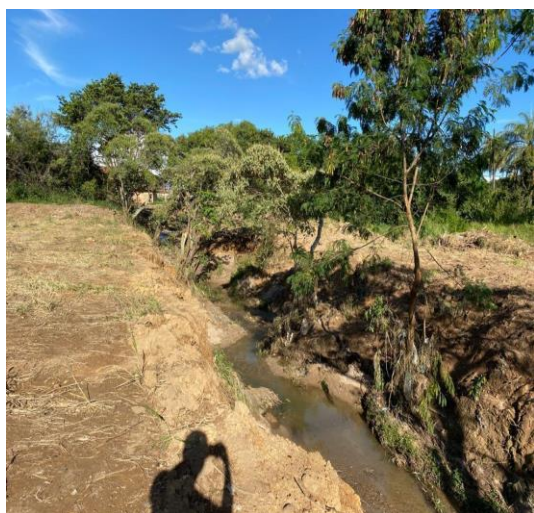
Figura 9 – Obra de limpeza do terreno
