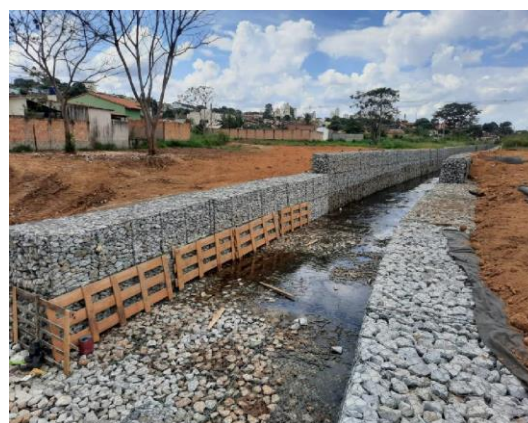
Figura 22 – Muros laterais de gabiões caixa
